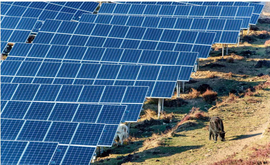
电力行业对阿坝工业经济贡献较大，图为小金县的光伏发电基地。
