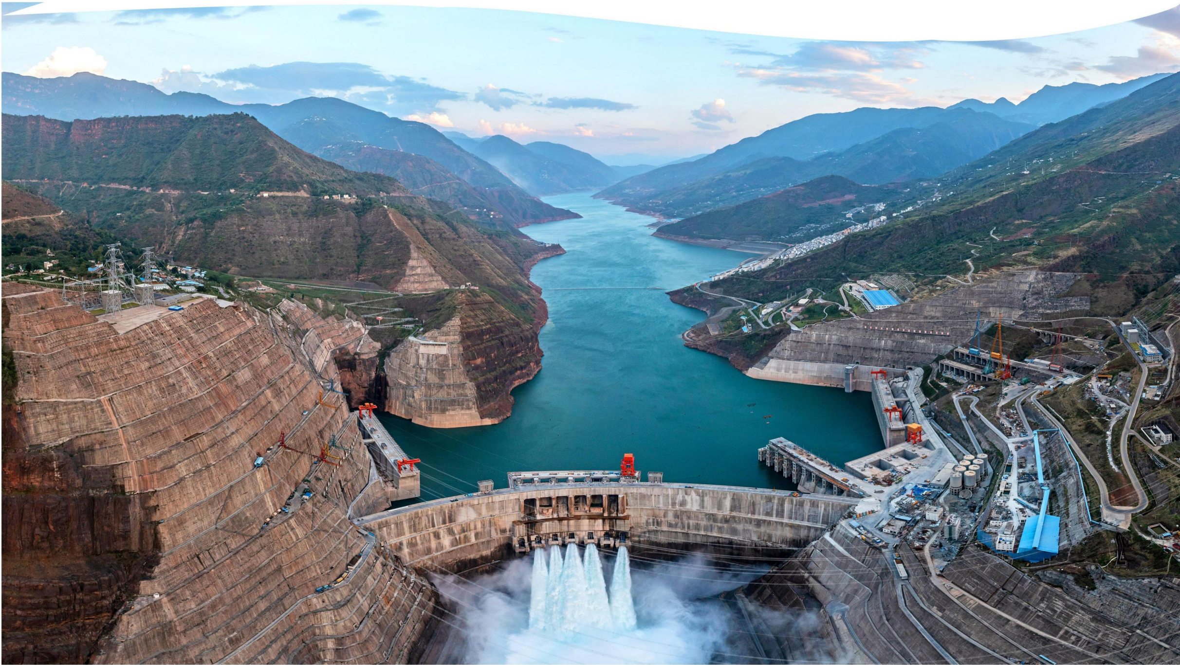
近年来，德阳研发制造了一大批“国之重器”。图为世界上单机容量最大的白鹤滩水电站，其左岸8台100万千瓦水电机组由东方电机研制。
