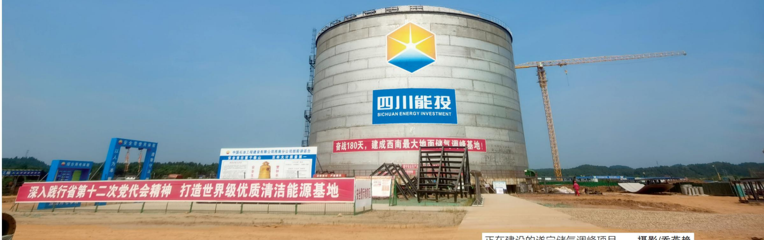
正在建设的遂宁储气调峰项目。 摄影/乔燕艳
