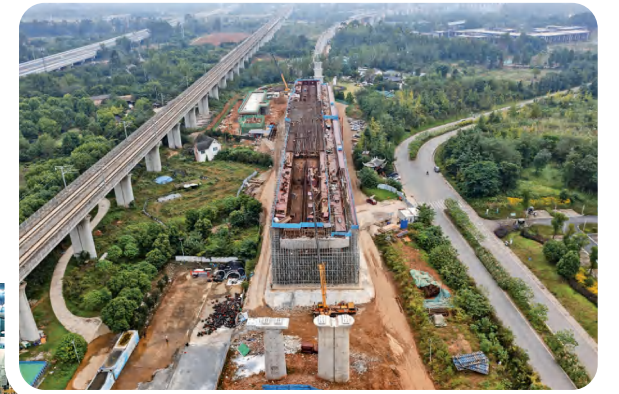
工程项目 建设力度加大，为项目如期完成奠定了坚实基础。
