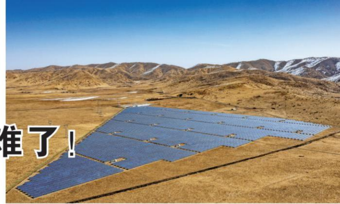
前三季度，四川以晶硅光伏、动力电池等为代表的绿色低碳优势产业快速发展，图为阿坝红原若羌光伏电站。
