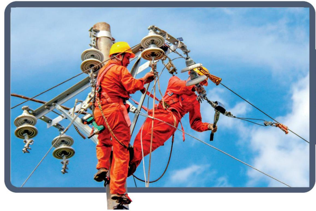
2022年7月，巴中市通江县的电力工人在高温下抢修作业，确保居民“清凉度夏”。
