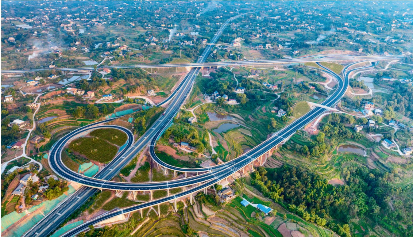
五年来，川渝省际高速公路通道集群不断织密。图为泸州叙永至永川段高速公路。
